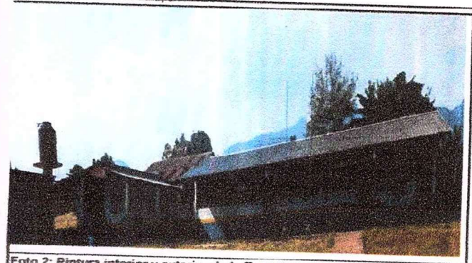
Foto 2: Pintura interior y exterior de la Escuela
