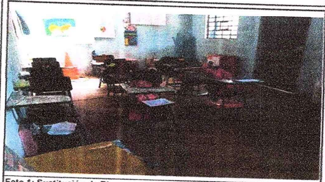
Foto 1: Sustitución de Piso
