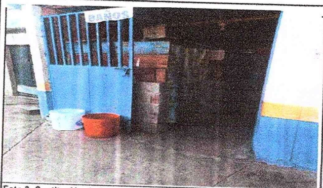
Foto 3: Sustitución de Baños
